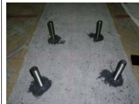
よう素フィルタを設置するための架台を支えるアンカーの打設を実施
