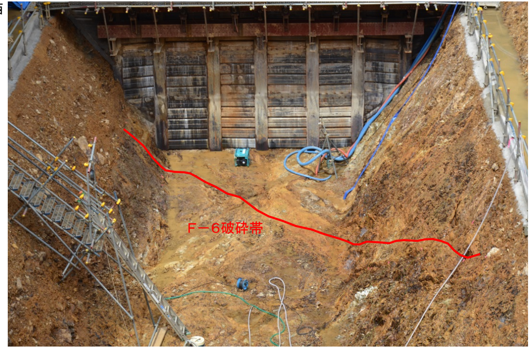
写真2(F-6破砕帯付近)
