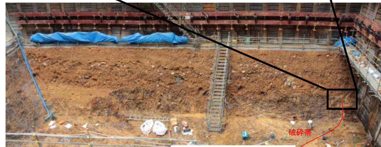
写真④(北側法面)
