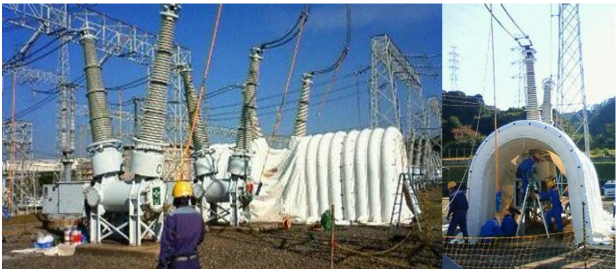
(参考)内部点検: ガス遮断器内部からSF6ガスを回収し、遮断部を分解して各部の点検を行う。
