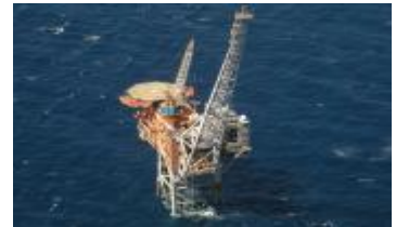
[ガス生産井プラットフォーム]
