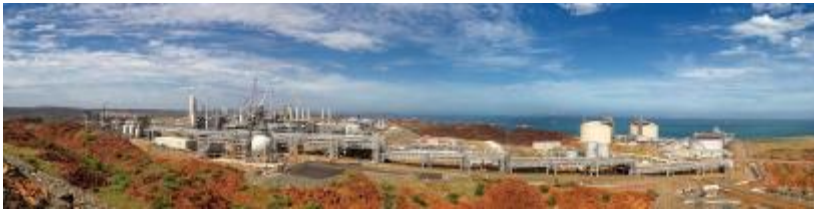
[プルートLNG液化基地]
