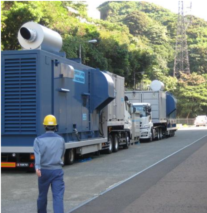
空冷式非常用発電装置
