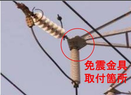
77kVの原子力電源線の長幹支持がいしについて、免震金具を設置する。
