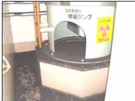
すずは動作した防火扉が隔離した範囲に留まっていた。
