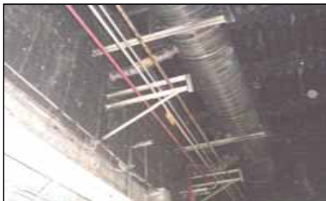
通路部は中2階と天井続きであり、高さも同じであることから高温の煙が流れ込み、天井(床上約7m)から床上約3.5mまでピッチ状のタールが壁面に付着していた。
