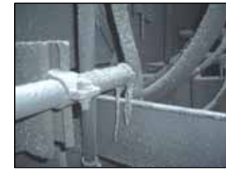
高温の煙により通路上の動力、制御ケーブルが損傷
