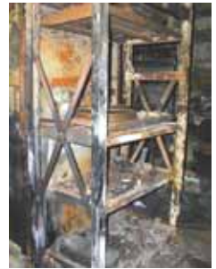
火災後の 工具棚の写真
