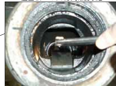
座金とアームの隙間確認状態
