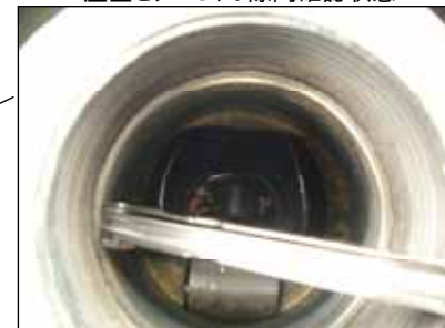
座金とアームの隙間確認状態
