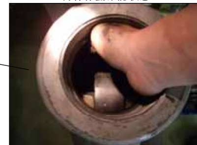
弁体作動確認状態
