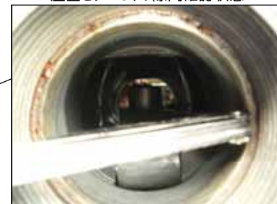
座金とアームの隙間確認状態
