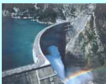
黒部川第四発電所 (33.5 万 kW、水力)
