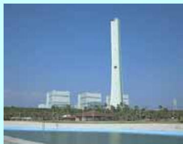
南港発電所 (180 万 kW、LNG 火力)
