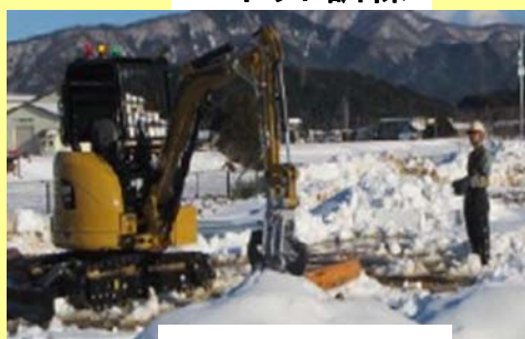
無線重機訓練
