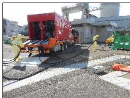
大容量ポンプホース敷設の様子
