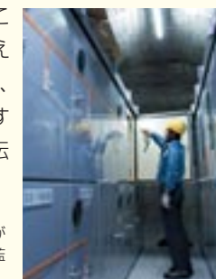
黒部ダムにはセンサーや測定器など電気設備がいたるところに設置されており、これらを点検・監視するのダムの保全作業の一つ
