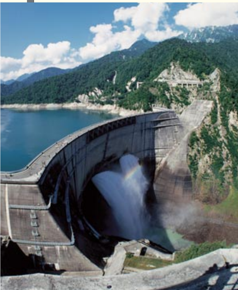
黒部川全体の年間発電量は約31億kWh——。安定した電気をお届けするため、黒部川電力システムセンターの業務は、ここ黒部ダムから始まる
