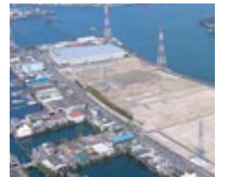
旭硝子(株)のPDP用ガラス製造工場は大阪住之江区の当社発電所跡地に
