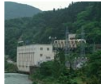
18年をかけた「水力発電所リフレッシュ工事」はこの小牧発電所で完了した
