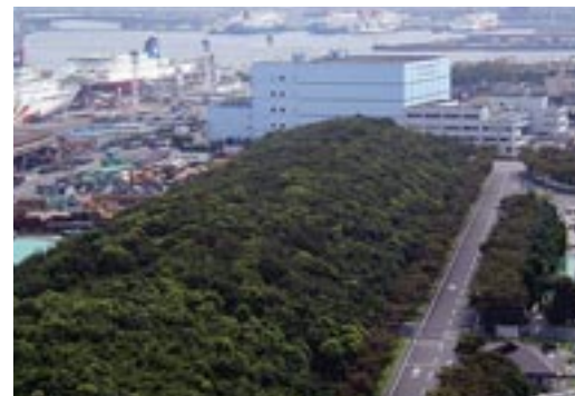
南港発電所のエコロジー緑化
