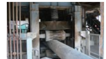
不用になったコンクリート電柱を粉砕
