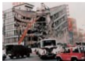
倒壊したビル
