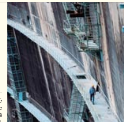
黒部ダムの高さは国内一の186m。堰堤に設けられたキャットウォークから堰堤外部や周りの山を監視して回る久保田水路長
