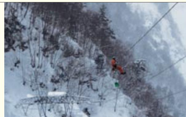
シャベルを腰に下げ、黒四発電所から送電線を伝い、鉄塔の除雪に向かう
