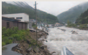
川の氾濫で切断された配電設備
