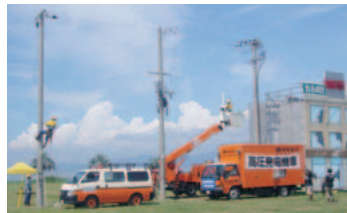
自治体主催の防災訓練で配電線の復旧作業を発表
