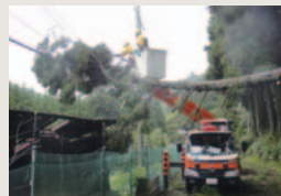
設備復旧のようす
