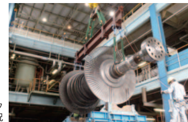
低圧タービンロータ点検後の搬入状況
