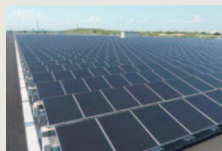
甲子園球場の約5倍にあたる21haの敷地に約7万4,000枚の太陽電池モジュールを敷き詰めた堺太陽光発電所
