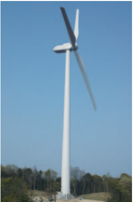
淡路風力発電所
