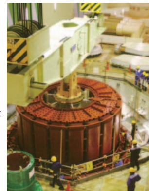
水力発電所の点検
