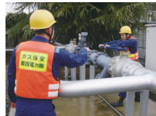
緊急時のガス供給弁閉止の訓練
