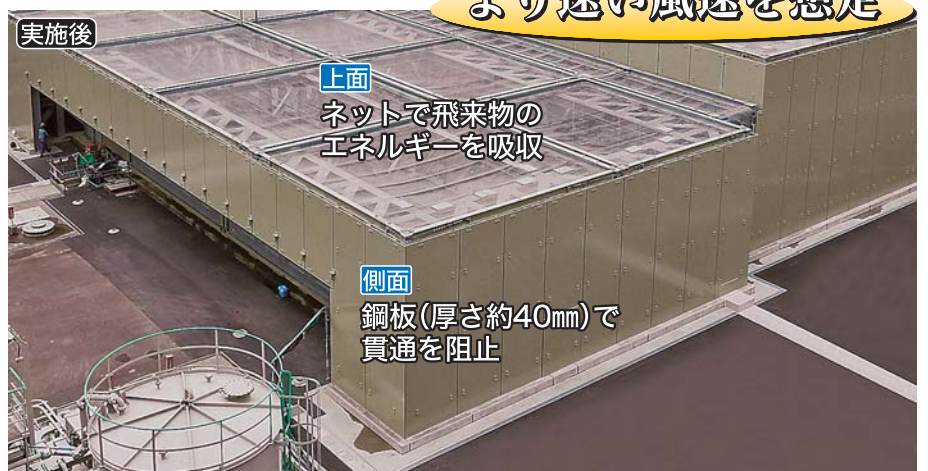
取水設備周りの竜巻防護対策(平成26年7月31日完了)
