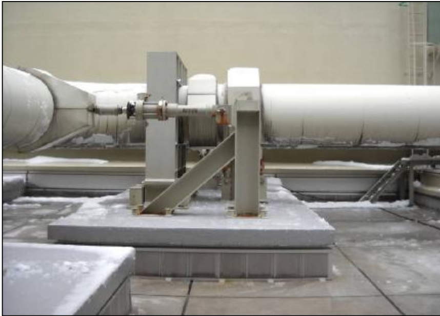
機器・配管の耐震評価およびサポート補強を実施
